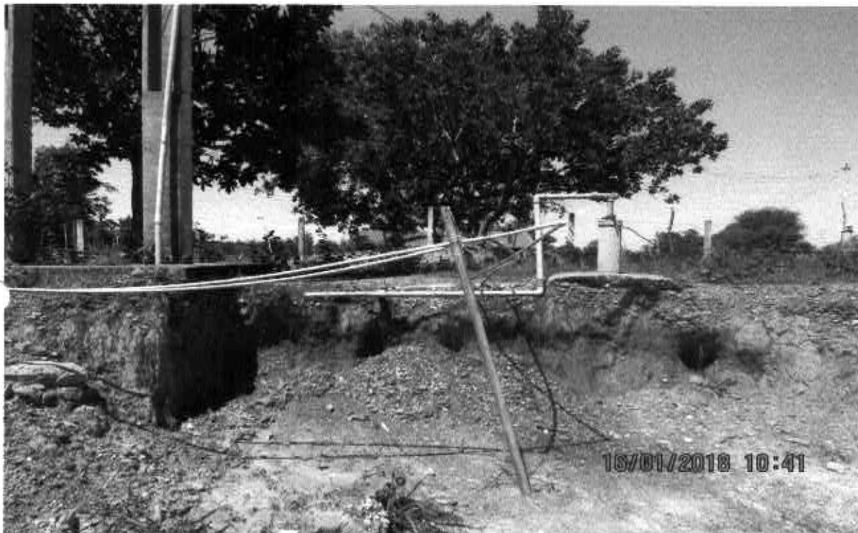
Fig. 64 – Poço Pov. Bom Sossego – Área delimitada do poço necessitando de reparos devido a desmoronamento de parte do terreno, não há aparelho dosador de cloro instalado, quer dizer, não há tratamento de água.
