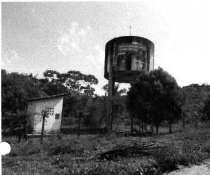
Fig. 53 – Poço 01 – Pov. Serra Dourada – Reservatório de concreto sem vazamentos, mas sem informações de última lavagem.
