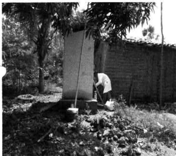
Fig. 58 – Poço Pov. Bejuí – Área do poço não é delimitada, presença de muitos resíduos sólidos e orgânicos. Água sem tratamento.
