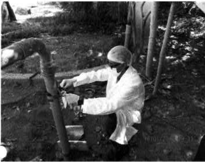
Fig. 73 – Poço 01 – Pov. Cerâmica Cil – Torneira direto do poço. Água com tratamento irregular.
