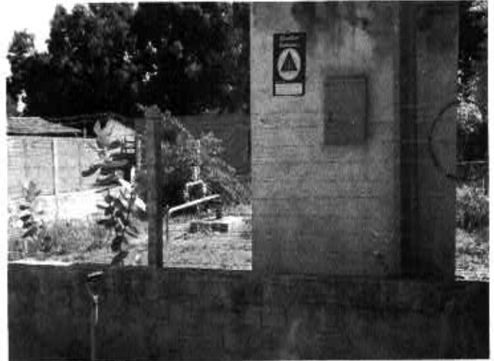
Fig. 40 – Poço 02 – Pov. Boa Hora – Área devidamente delimitada e com casa de apoio em bom estado de conservação.
