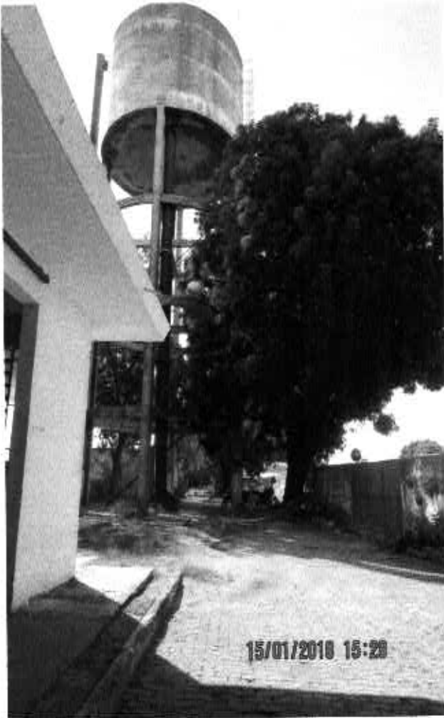
Fig. 17 – Centro de Reservação Jockey
