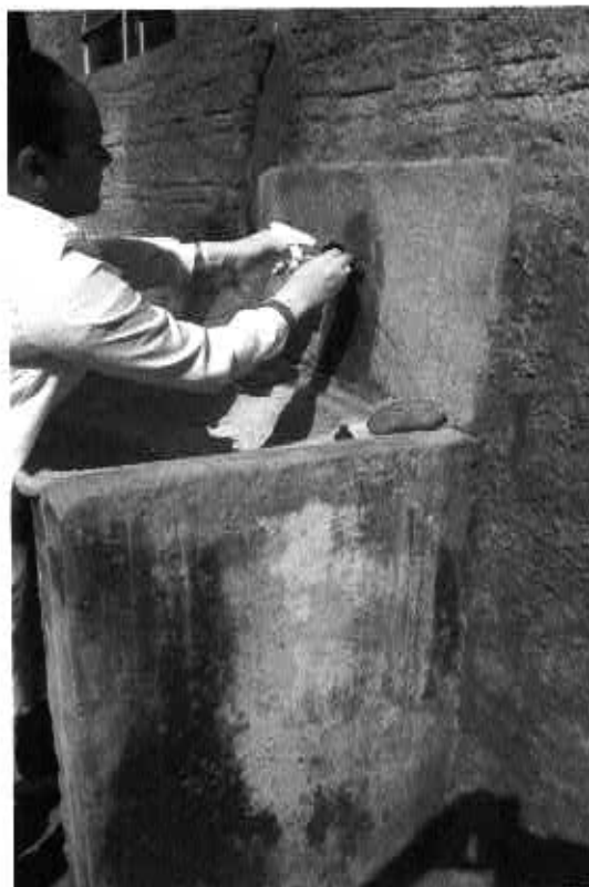
Fig. 23 – Torneira da rede de distribuição – bairro Colorado
