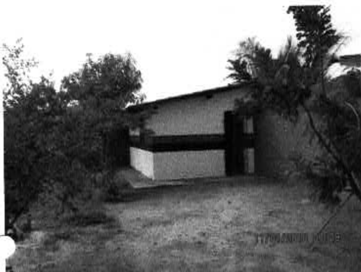
Fig. 13 – Casa de apoio em ótimo estado de conservação Centro de Reservação Parque Brasil
