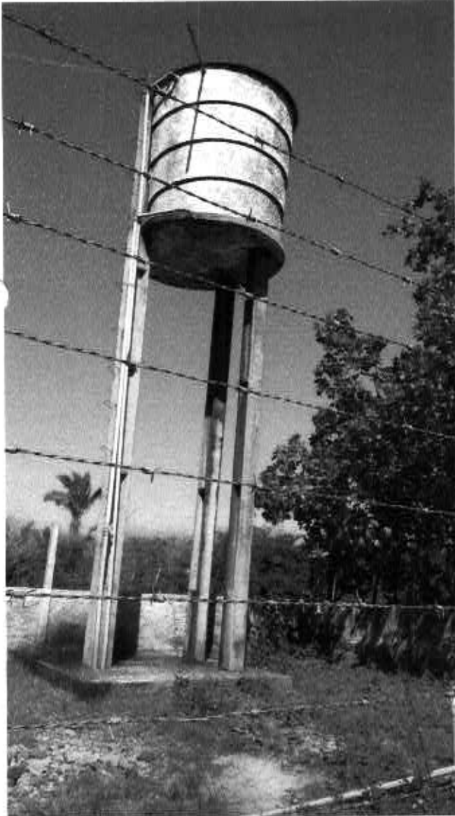
Fig. 44 – Poço Pov. Portal do Parnaíba – Área devidamente delimitada e com reservatório tampado e bom estado de conservação, mas sem informações sobre a última higienização.
