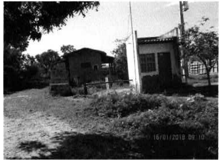
Fig. 74 – Poço 02 – Cerâmica Cil – Área do poço sem delimitação e Casa de Apoio necessitando de reparos.
