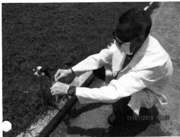
Fig. 36 – Ramal alimentada por água oriunda da saída do Tratamento de água da ETA III.
