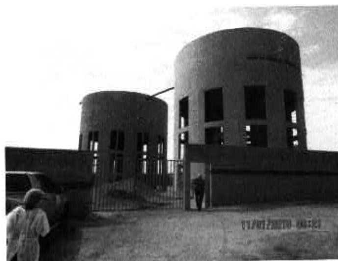
Fig. 12 – Centro de Reservação Parque Brasil - Área devidamente delimitada e com identificação
