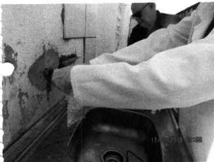
Fig. 27 – Torneira alimentada por água oriunda da rede de distribuição. Centro de Saúde Augusto Castro – Santo Antônio
