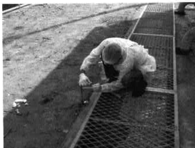
Fig. 04 – Ramal alimentado com água Oriunda da Saída do Tratamento.
