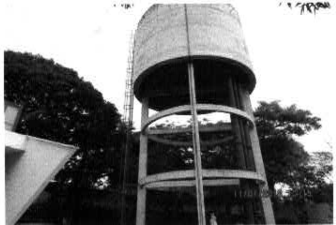
Fig. 08 – Centro de Reservação do Buenos Aires
