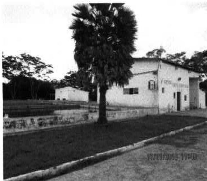
Fig. 35 – ETA III – Complexo de ETA's Polo Sul
