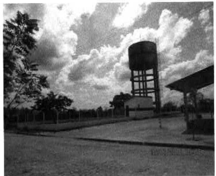
Fig. 31 – Centro de Reservação Eduardo Costa. Área devidamente delimitada e identificada em ótimo estado conservação.
