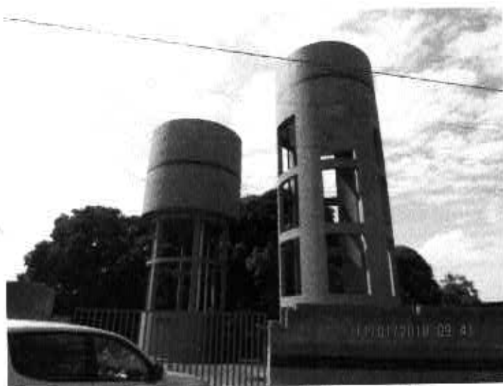
Fig. 15 – Centro de Reservação Santa Maria da CODIPI – Área devidamente delimitada, com identificação e fechada. A equipe de coleta não teve acesso.
