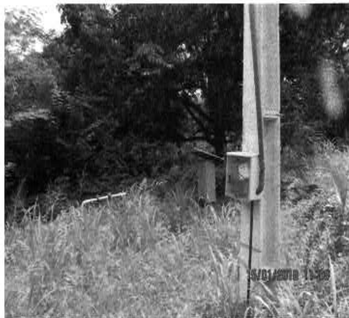
Fig. 59 – Poço Pov. Calengue – Área do poço sem delimitação, com presença vegetação cobrindo o poço, caixa de energia onde qualquer pessoa tem acesso.
