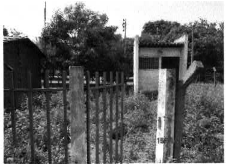
Fig. 48 – Poço 01 – Pov. São João – Área do poço delimitada, mas precisando de reparos e capina. Casa de apoio necessitando de reparos e trancas.
