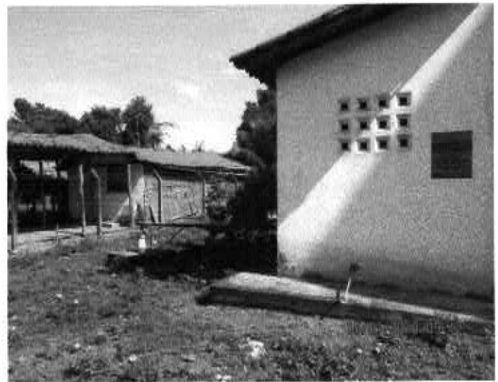
Fig. 50 – Poço 01 – Pov. Serra Dourada – Área devidamente delimitada, poço com barreira sanitária e Casa de apoio em bom estado de conservação.
