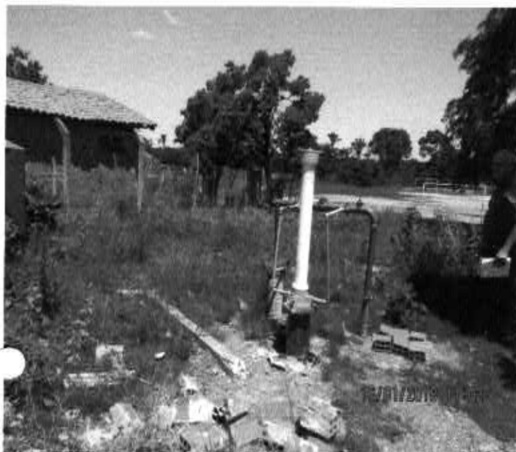
Fig. 77 – Poço Maria Alice – Pov. Cerâmica Cil – Área do poço sem delimitação, com vegetação crescida, presença de resíduos sólidos. O poço possui dosador de cloro instalado funcionando com teor mínimo de cloro.
